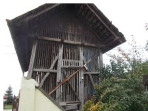
A bejárata felől, a ferde építmény előtt a pince bejárata.
